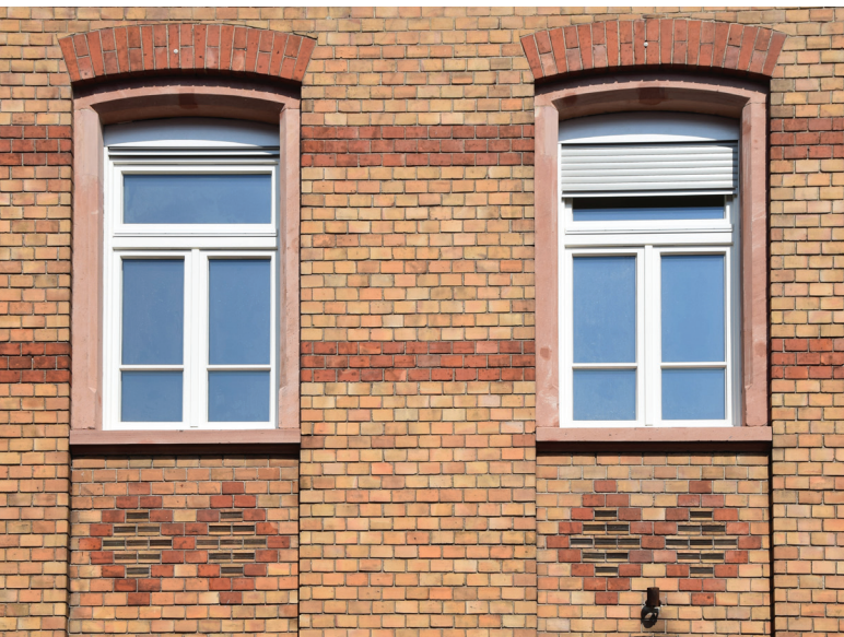
Lochfassade aus Mauerziegeln
