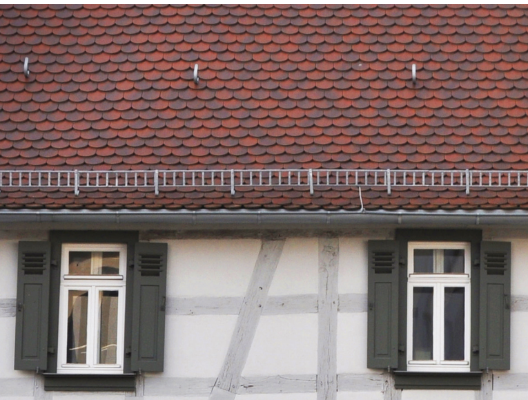
Biberschwanzdeckung im rot-braunen Farbspektrum
