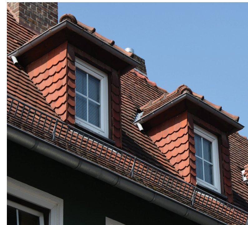
Stehende Walmdachgaube mit Ziegeldeckung und -bekleidung
