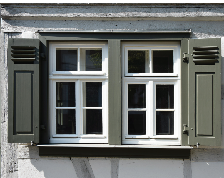
Doppelfensteranlage mit Sprossengliederung und Klappläden
