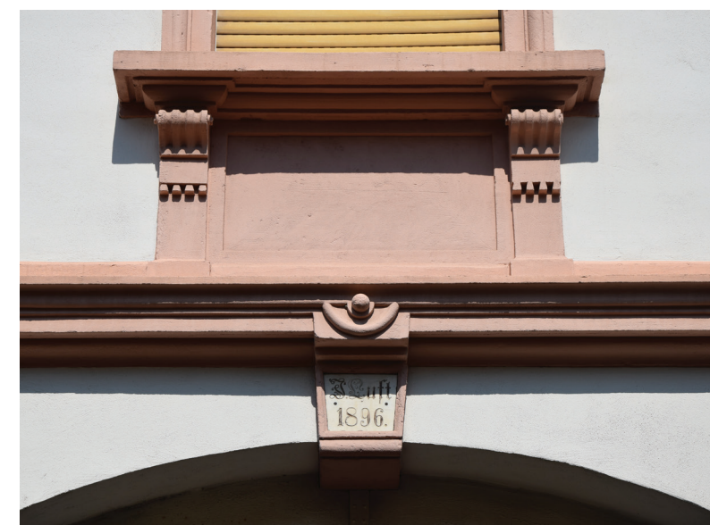
Gesims oberhalb eines Torbogens mit Schlussstein
