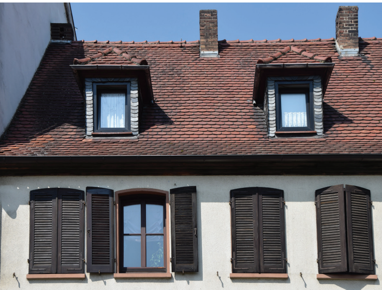
Satteldach mit Biberschwanzdeckung und stehenden Walmdachgauben
