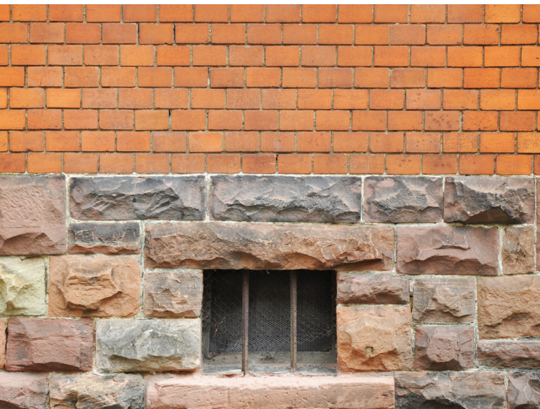
Mauerziegelfassade auf Gebäudesockel aus Naturstein
